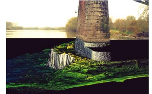
**Рис. 2.** Визуализированное изображение опоры моста по результатам обследования VRT
